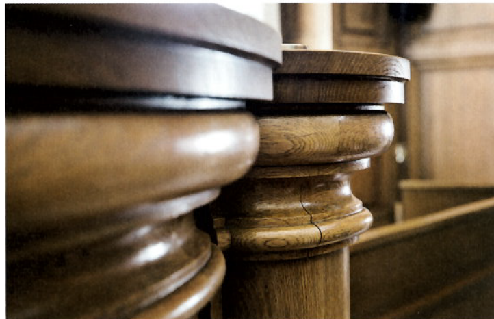
Den gamle talerstol er blevet sat i stand. Dele er blevet udskiftet, bl.a. er der lagt nye bordplader på. Revner er udbedret, og hele talerstolen er blevet lakeret. Foto: Ty Stange
