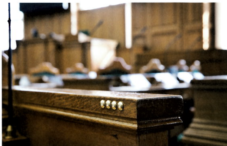
For at forbedre orienteringsmulighederne for mennesker med synsnedsetelse har bordrækkerne fået taktile markeringer, der viser rækkefølgen. De er udført med almindelige møbelsøm i messing. Foto: Ty Stange
