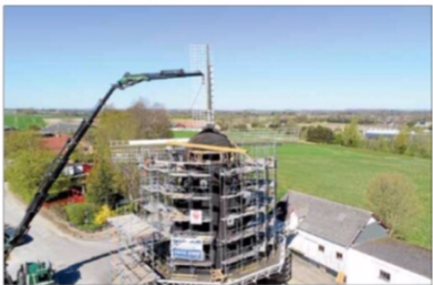
Nr. Jernløse Mølle er i øjeblikket pakket ind i et stillads, ligesom der må en kran i brug for at klare arbejdet med renoveringen.
